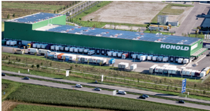
Große Dachflächen dienen im GVZ Region Augsburg der umweltfreundlichen Stromerzeugung.
